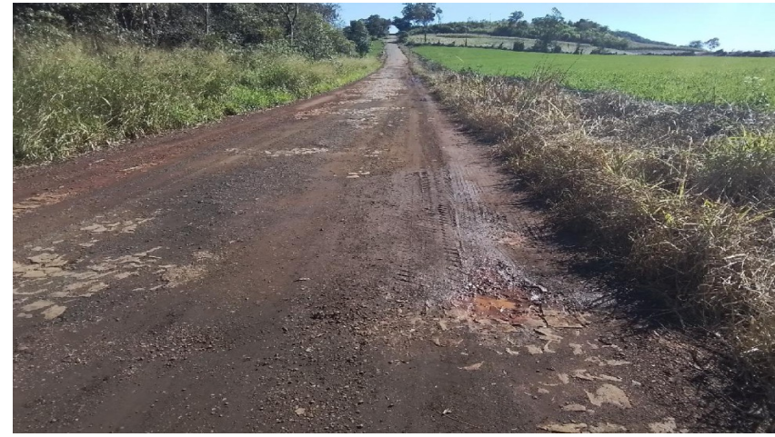
Foto 4 – Bueiro a instalar (Ø60) - Largura atual 6,0 m
